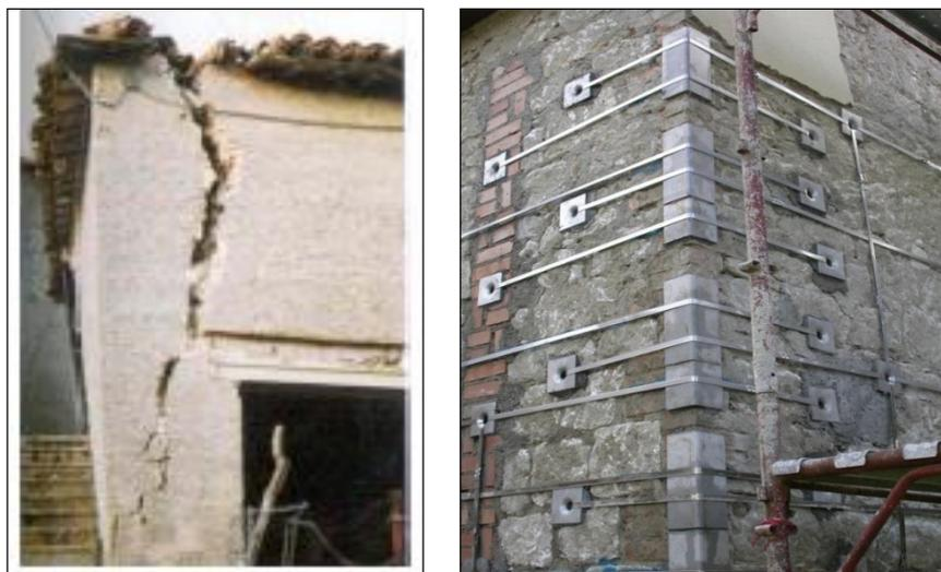
FIGURA 17 - RISOLUZIONE DEL PROBLEMA DELLE CONNESSIONI TRA PARETI ORTOGONALI CONTRASTANDO IL RIBALTAMENTO DEI PARAMENTI MURARI E REALIZZANDO UN REALE COMPORTAMENTO A SCATOLA
